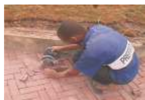
acabamento com disco de corte
