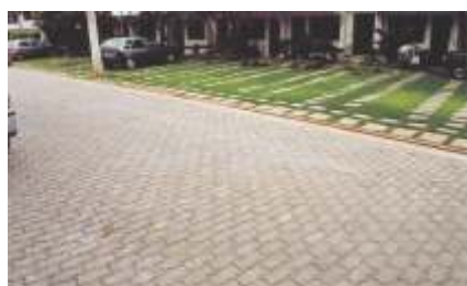
assentamento tipo linear
