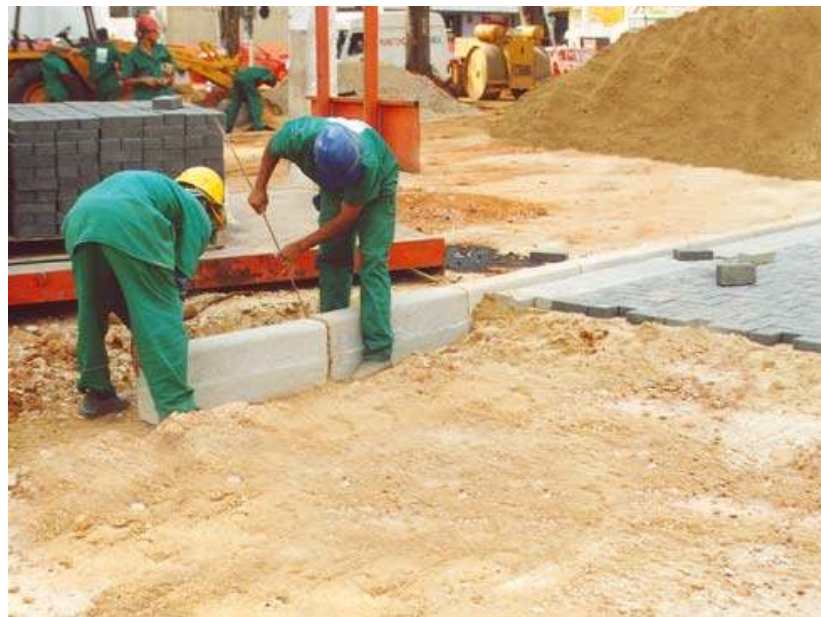
Figura 3 - Colocação de confinamento externo (meio-fio)
