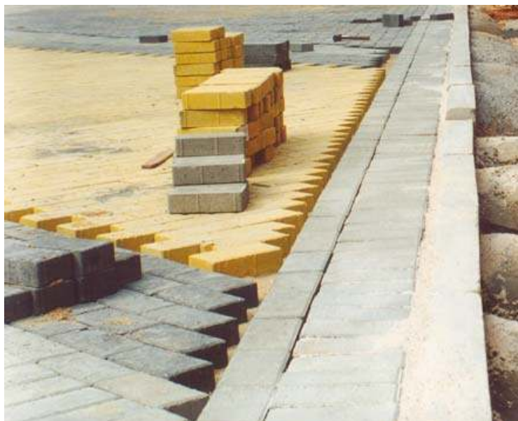
Figura 5 - Confinamento externo (meio-fio)
