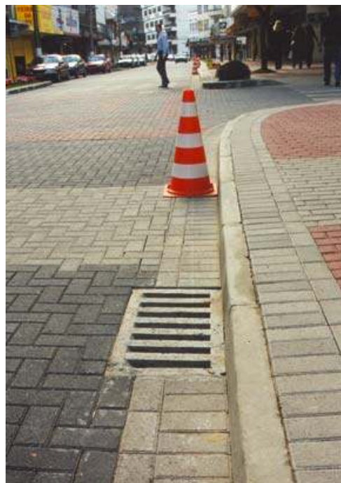
Figura 1 - Confinamento externo (meio-fio)
